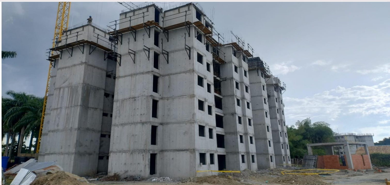
TORRE A - ESTRUCTURA
